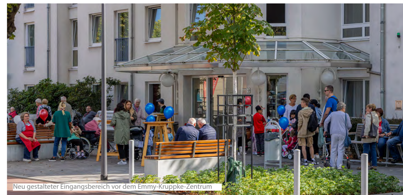
Die Thingstraße während der Umbaumaßnahmen
