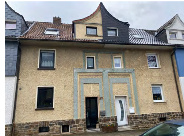
neuer Anstrich für ein Gebäude in der Gartenstadt Hüttenau
